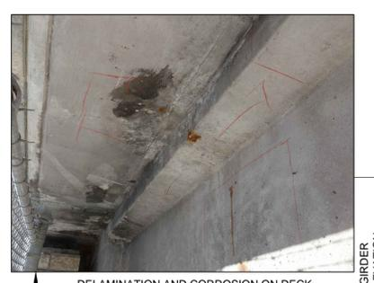
DELAMINATION AND CORROSION ON DECK CANTILEVER AND EXTERIOR SIDE OF TOP FLANGE AND WEB ON GIRDER W1-2 No.7
