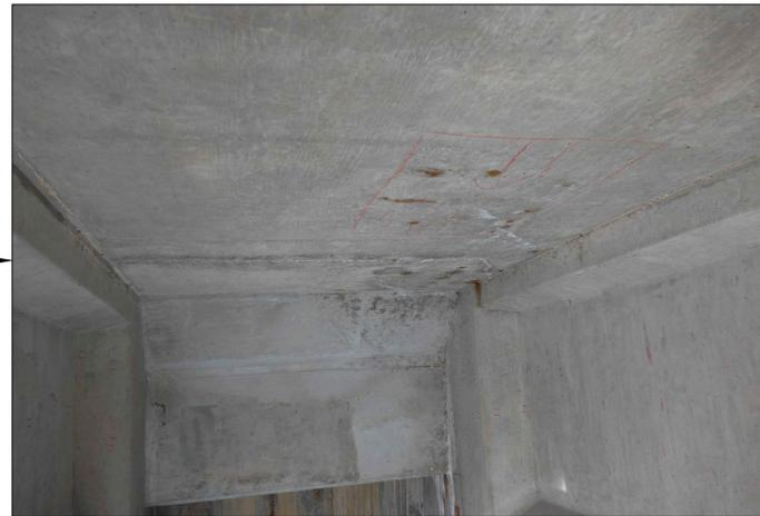
TYPICAL DECK SOFFIT DELAMINATION AND RUST STAINING
