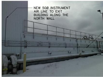
NEW 500 INSTRUMENT AIR LINE TO EXIT BUILDING ALONG THE NORTH WALL
